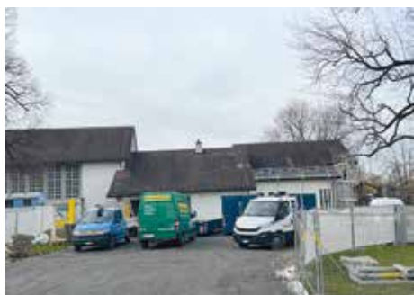
Momentaufnahme der Bauarbeiten im Februar 2024
