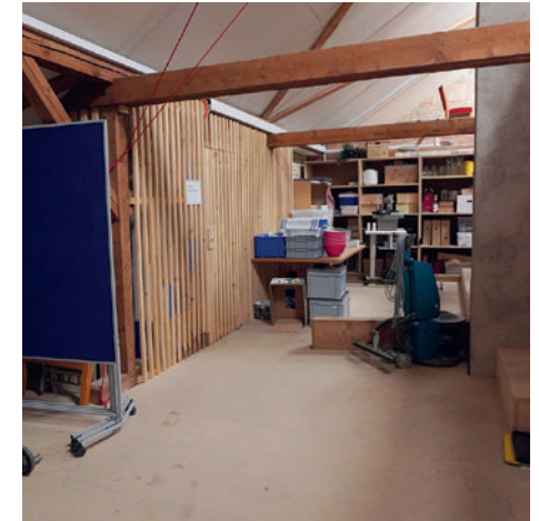
Lagerräume im Estrich ohne Lift
